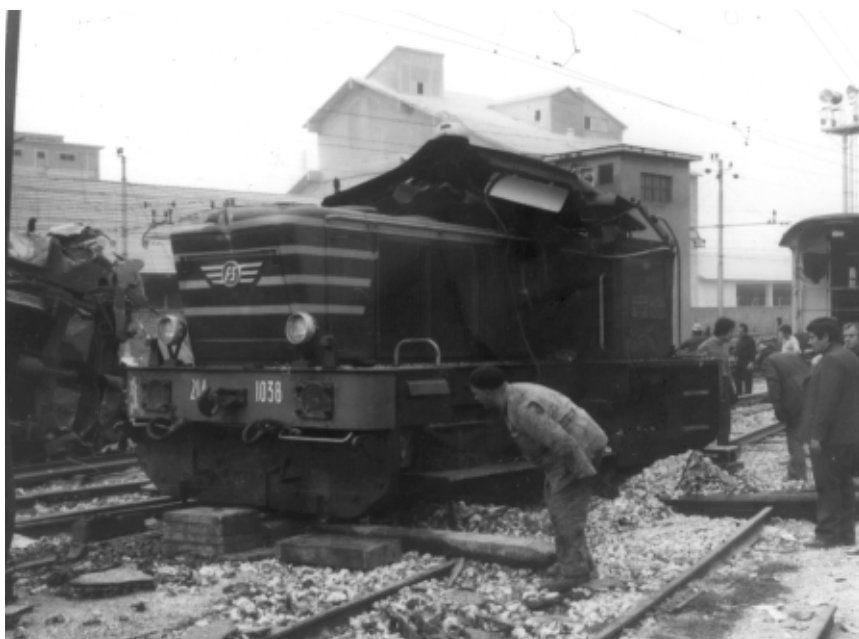
Il locomotore Diesel da manovra, sbalzato dal binario nel tremendo urto, è oramai semidistrutto (foto alfa).
