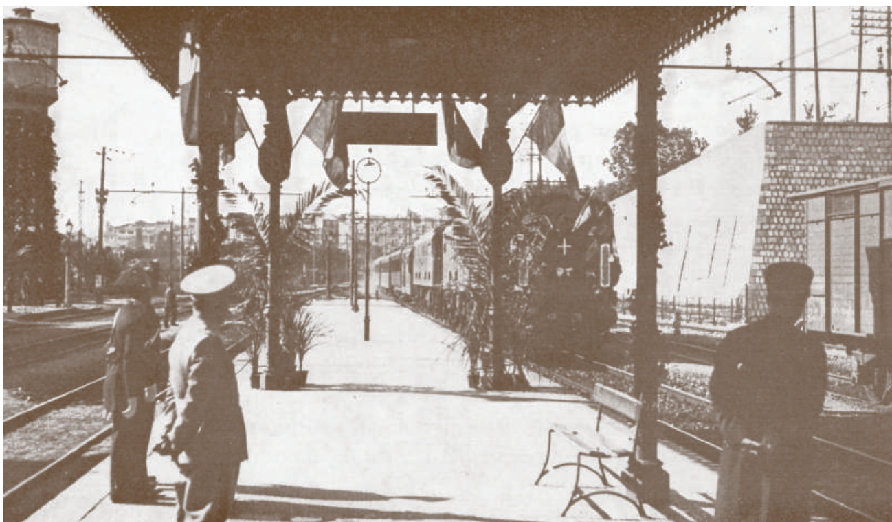
La stazione di Villa Literno con il suo ampio piazzale adeguato all'intenso traffico.
