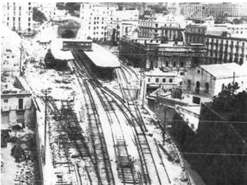
La costruzione della stazione di Mergellina. Si noti, sulle due pensiline, la presenza della cabina degli scambi, in seguito eliminata.
