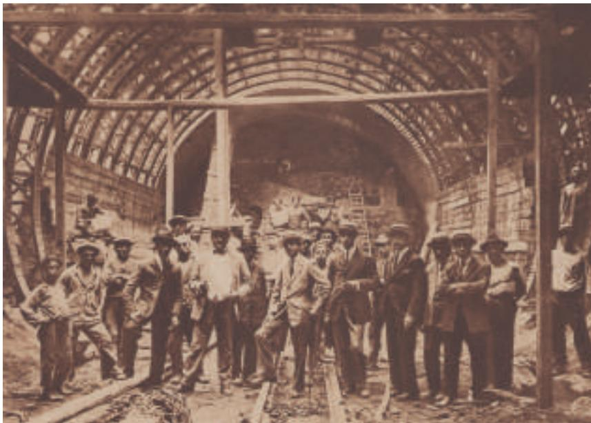
Galleria sotto l'abitato di Napoli – Armatura in ferro rivestito di cemento (foto FFSS).
